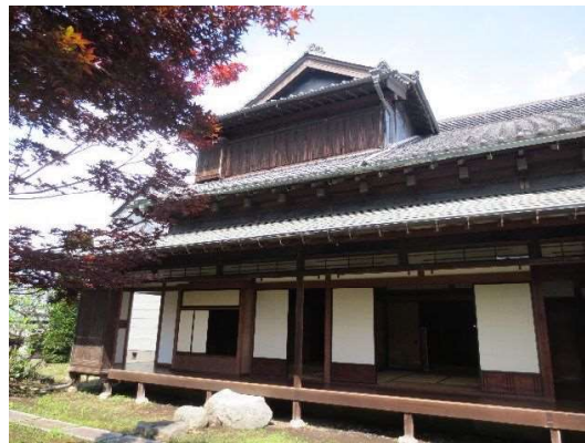
主屋一階 西側廊下
