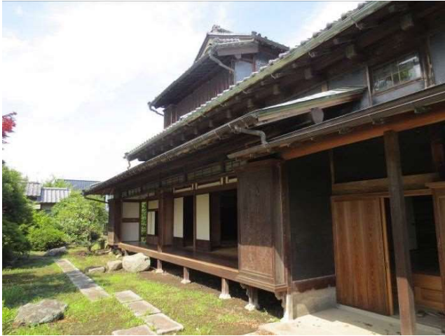
店舗及び主屋の縁側
