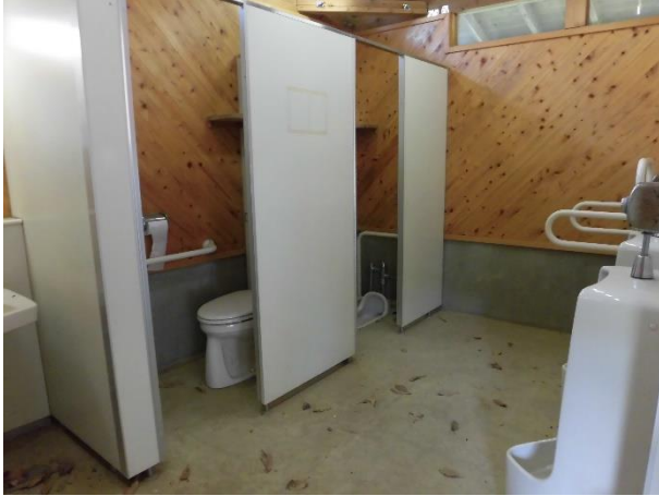
▼屋外トイレ内観
