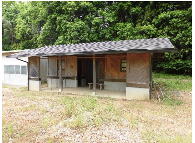
▼屋外トイレ外観
