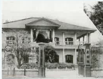
●明治31年(1898)行幸時を再現した泉布観(『大阪市立北区実科女学校創立十周年記念』大正15年より) 明治天皇の行幸にあわせて、建物を飾り立てていた。また、当時は大川に面した東側正面に門があった。
