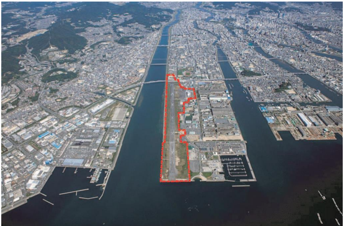
図1 広島西飛行場跡地 全景（平成28年11月広島市撮影）
