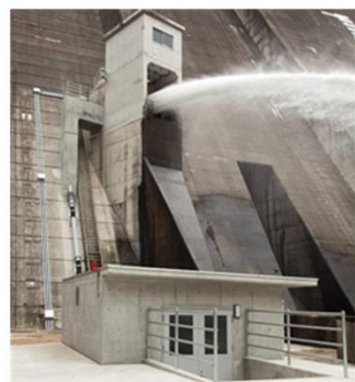
【発電設備の新設・増強】
