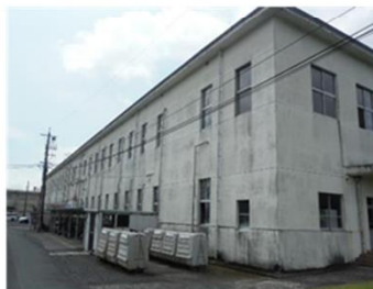
【現状施設の例(庁舎)】
