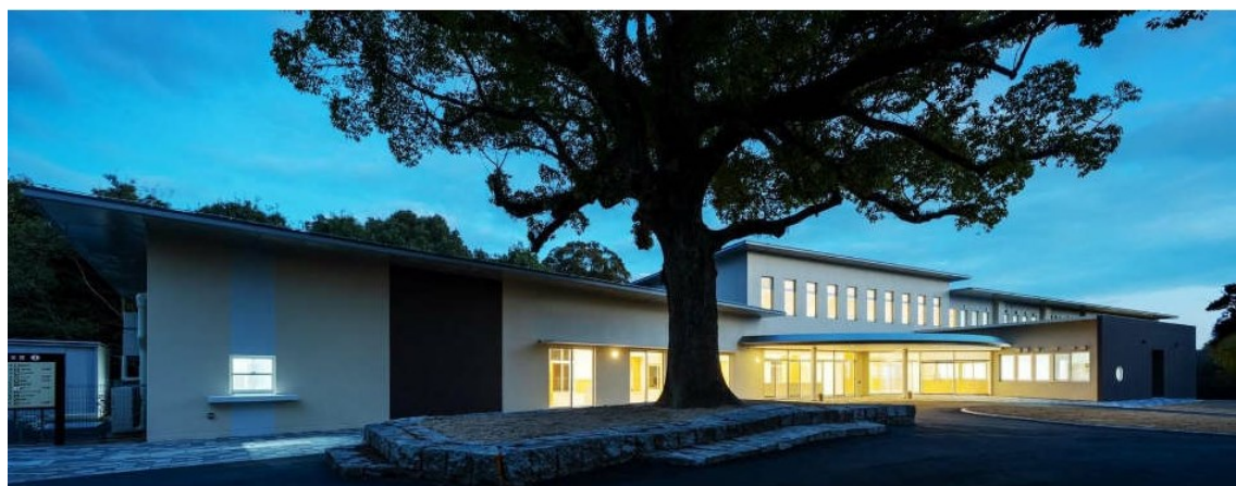
※倉敷市自然の家HPより
