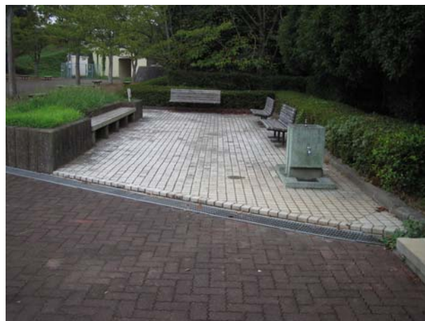
●通路間の段差による弱者に対するバリア
