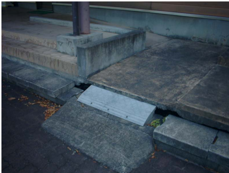
管理棟への出入り口に設けられた仮設坂路
