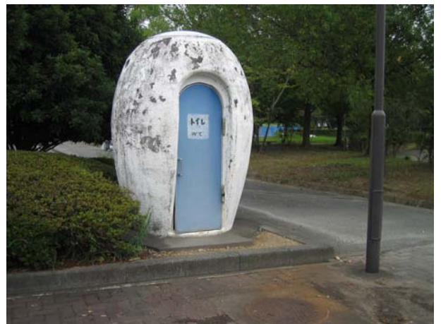
●トイレの老朽化と弱者に対するバリア
