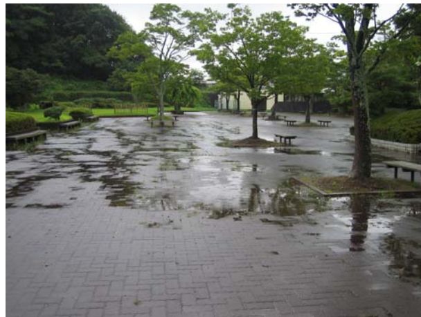
●表面排水の機能不全
