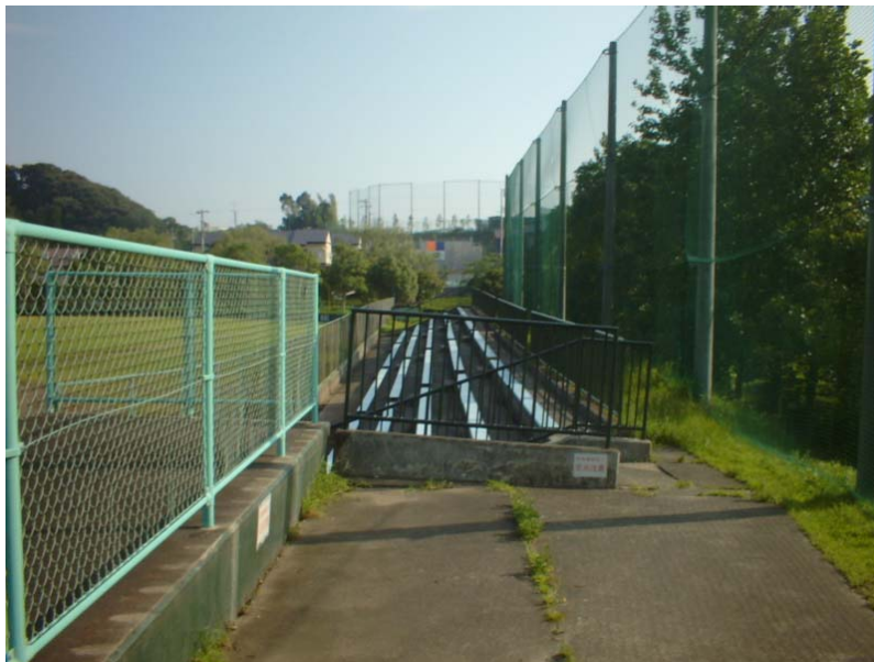
傾斜したライト側スタンド
