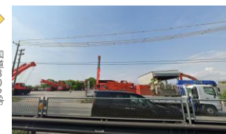
図 国道 23 号から見た本施設
