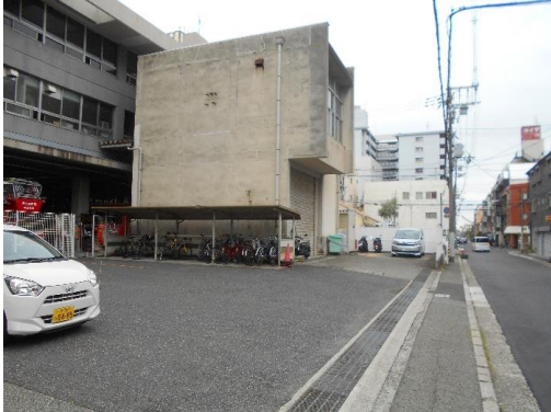
倉庫棟（写真②）
