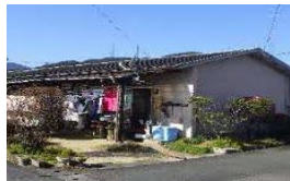
▼町営園部団地 （昭和41～49年建設）
