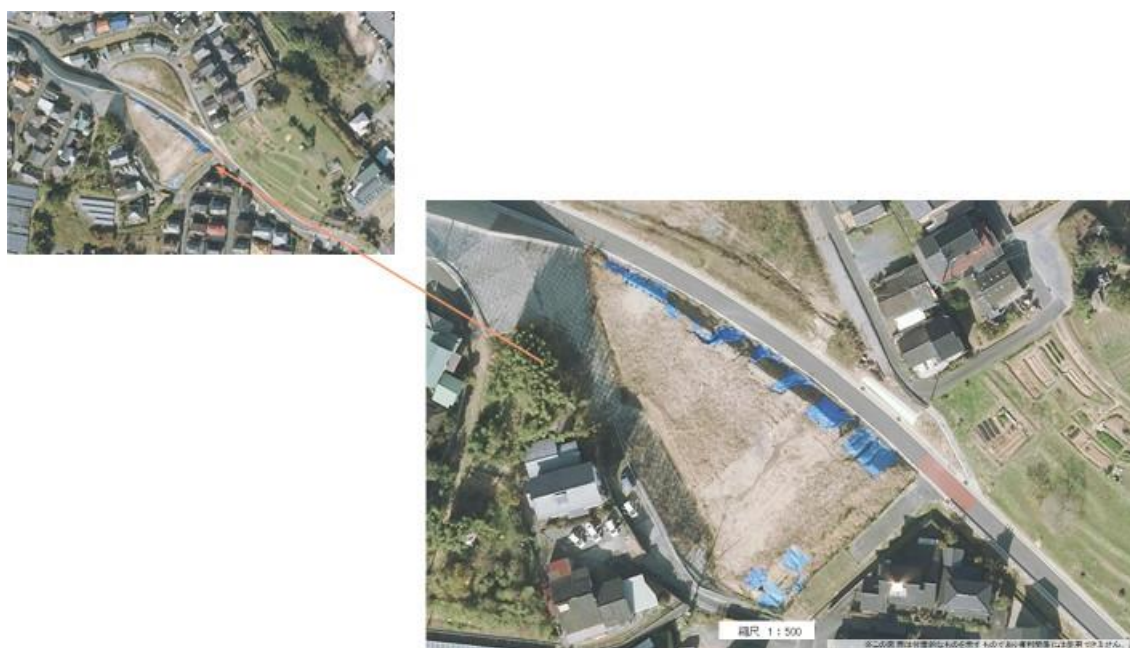
図 15 建替え候補地②の敷地状況
