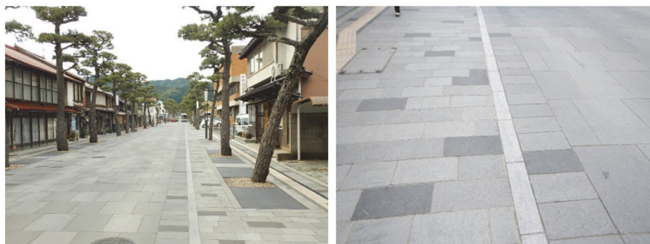
区画線を白御影とし、グレー2色と黒御影を配合した路側帯の舗装パターンが車道側へにじみ出すように設置(島根県出雲市 神門通り) 資料提供:島根県
