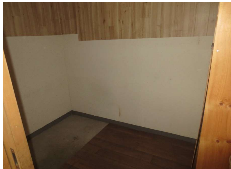
休憩室（旧倉庫）
