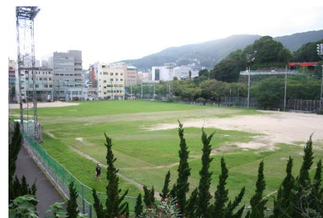
施設の老朽化が進んでいたスポーツ広場
