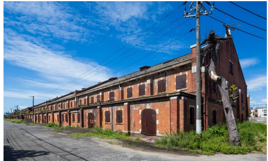
(煉瓦造の外壁)
