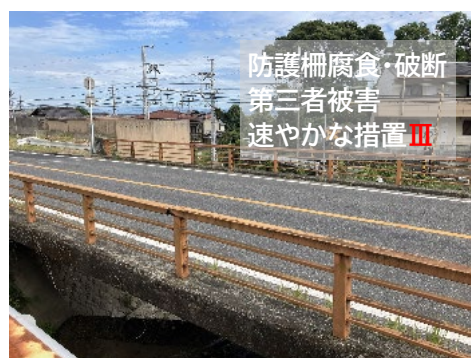
写真-3.1.2 四ツ谷川橋 防護柵状況*
