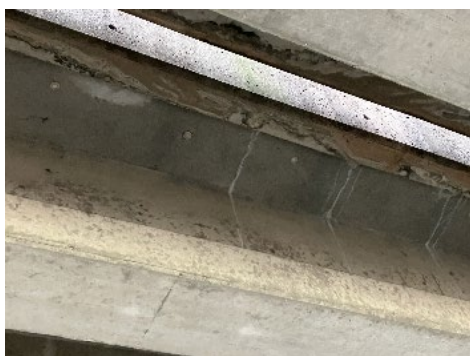
写真-3.1.15 大力橋 桁下状況*
