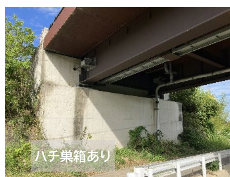
写真-3.1.8 新豊川橋 橋台部状況*
