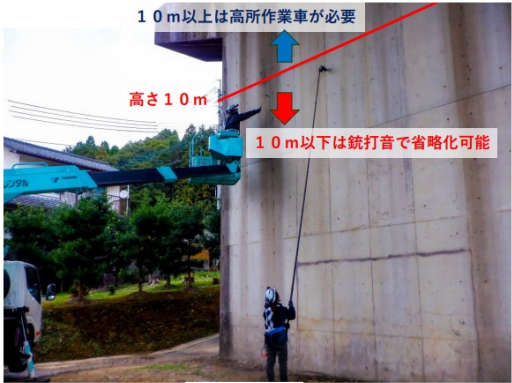
写真-4. 6. 3 新工法による打音検査例
