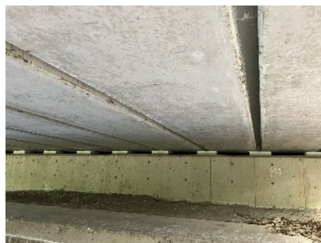
写真-3.1.10 目田川橋 桁下状況*
