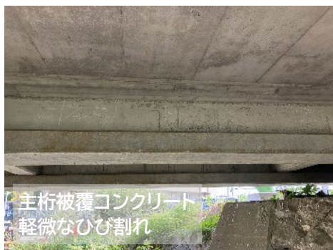
写真-3.1.3 四ツ谷川橋 桁下状況*
