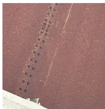
写真-3.1.6 新豊川橋 鋼桁状況*
