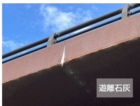
写真-3.1.7 新豊川橋 壁高欄状況*
