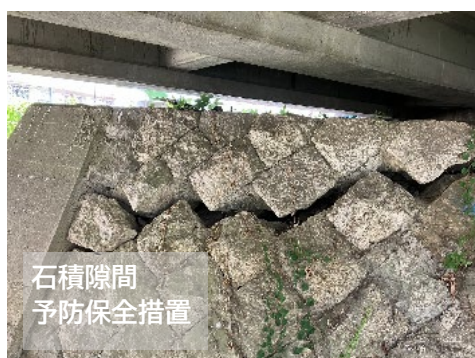
写真-3.1.1 四ツ谷川橋 石積状況*
