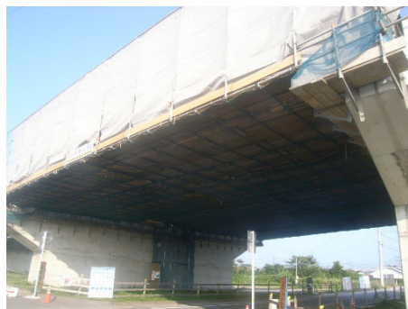
写真-4.6.2 修繕工事の足場例*
