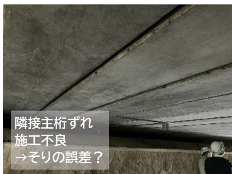
写真-3.1.9 目田川橋 桁下状況*
