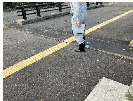
写真-3.1.12 目田川橋 橋面状況*
