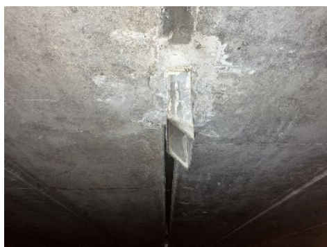
写真-3.1.11 目田川橋 排水状況*
