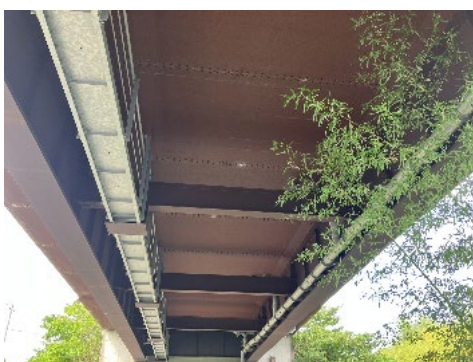
写真-3.1.5 新豊川橋 桁下状況*
