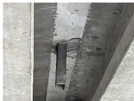
写真-3.1.16 大力橋 排水状況*
