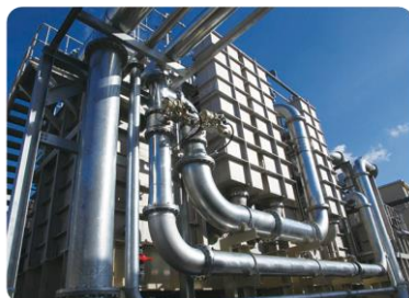
下水処理設備
