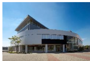
（施設外観（北東メイン入り口側））
