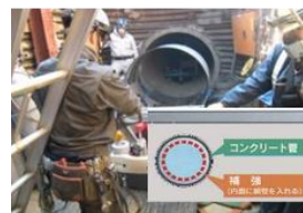
例：管路の耐震補強
