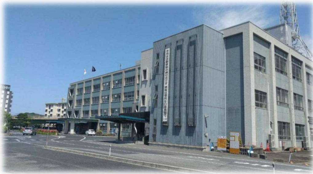
西部総合事務所 既存棟
