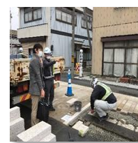
舗装施工助言の例（弊社実績）
