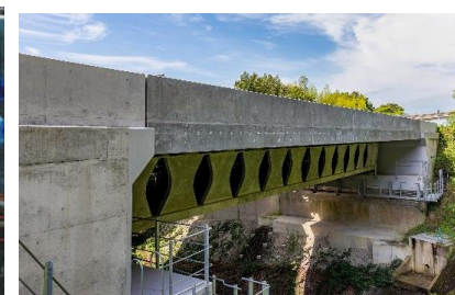
写真-3 非鉄製橋梁（別埜谷橋）（西日本高速道路（株）との共同開発）
