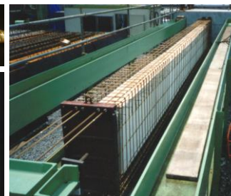
写真-2 AFRPロッドを用いたプレテンション桁製作状況
