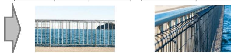
改修後：外径Φ4.6mmのフェンスをステンレス結束バンドで固定
