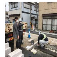
舗装施工助言の例（弊社実績）
