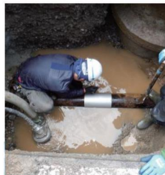
配水管漏水修理の様子
