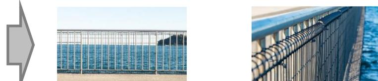
改修後：外径Φ4.6mmのフェンスをステンレス結束バンドで固定
