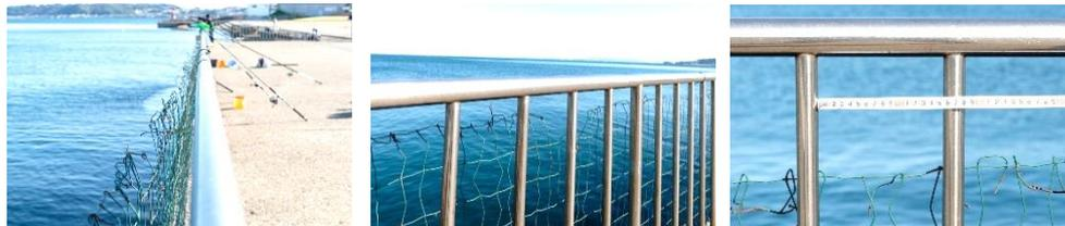
改修前：経年劣化で樹脂結束バンドが割れ落ち、金網が千切れている（すき間：155mm）
