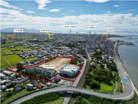
＜ 航空写真（北側からみた風景） ＞
