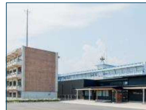
気仙沼市 東日本大震災遺構・ 伝承館（宮城県気仙沼市）
