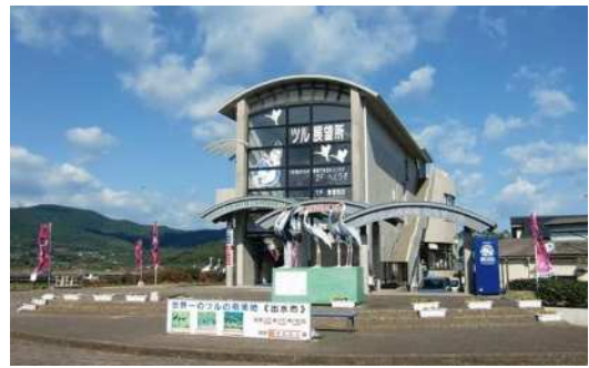
出水市ツル観察センター
