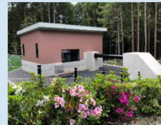
【岐阜県中津川市】 神坂霧ヶ原小水力発電 自主事業：JV企業として事業実施中
