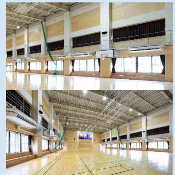
【大分県別府市】 小学校体育館空調設備導入：DB方式
