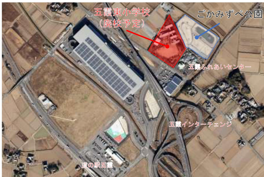
▲ ごかみずべ公園と廃校後の活用を検討している五霞東小学校
