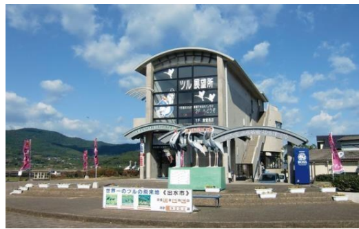
出水市ツル観察センター
