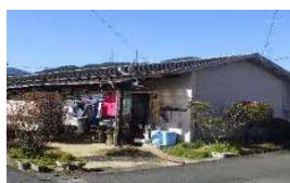
▼町営園部団地 （昭和41～49年建設）
