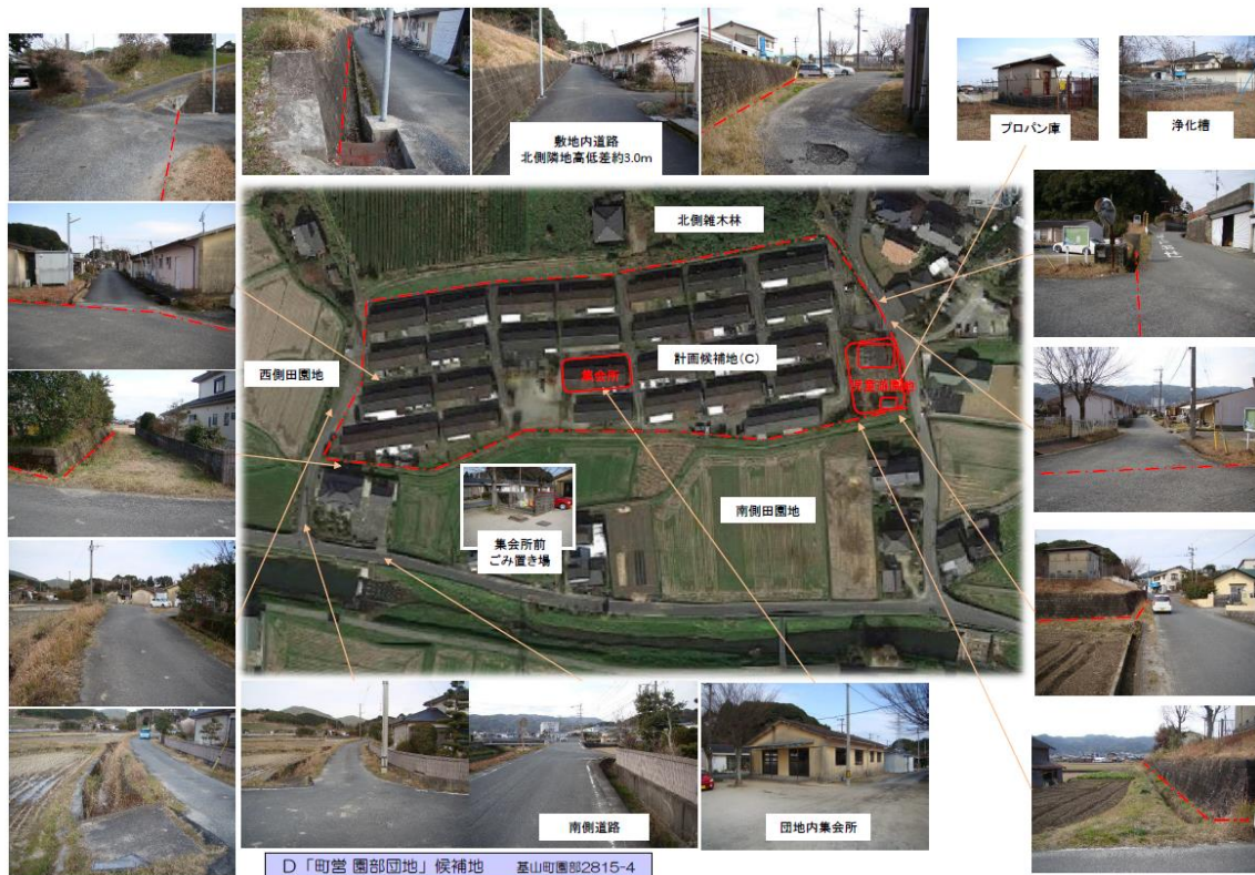
図 11 町営園部団地の既存建物の敷地状況
