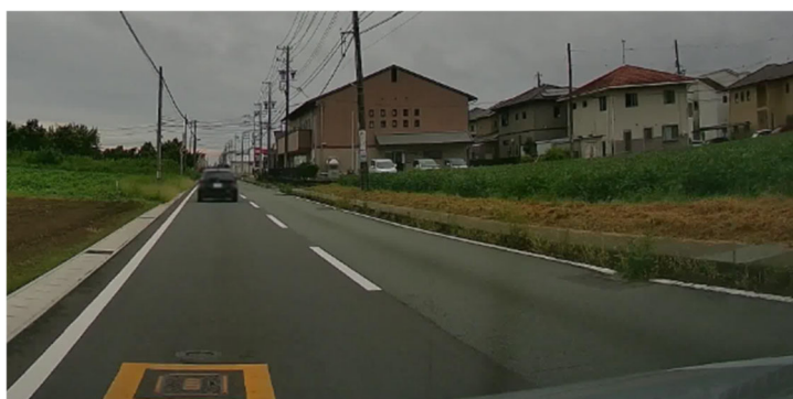
図 5-8 ドライブレコーダーに撮像された水道設備 (手前が水道四角弁、そのやや上方が水道仕切弁丸)
