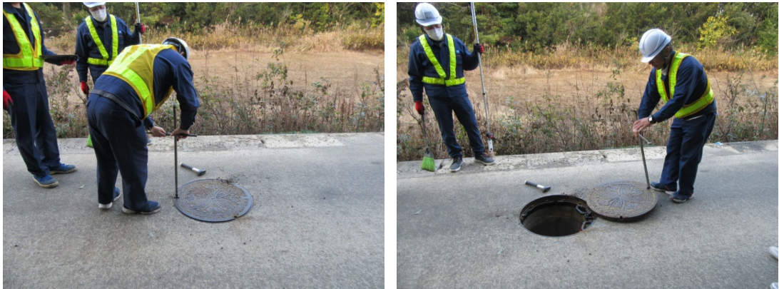
図 5-16 下水道マンホールの蓋開け
