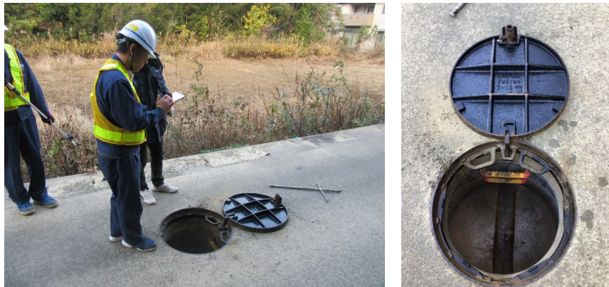
図 5-17 マンホールの蓋（裏）の点検
