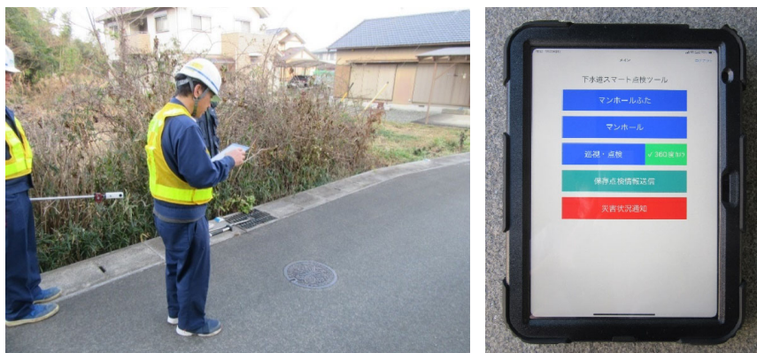
図 5-14 点検対象マンホールの登録
