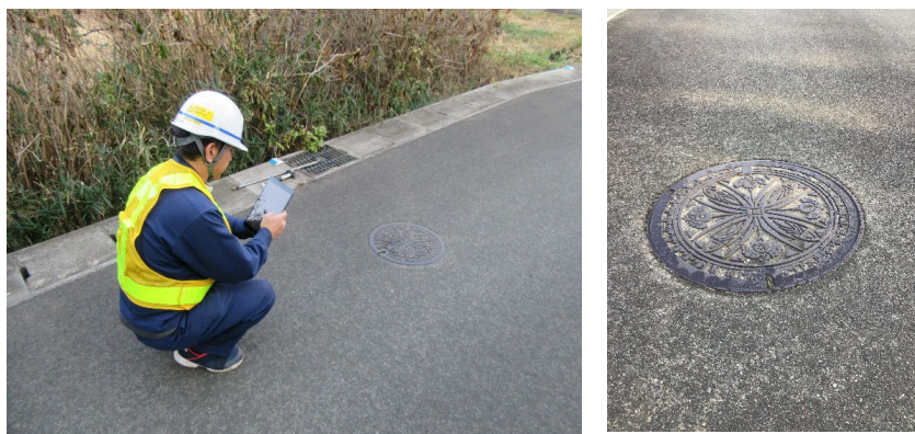
図 5-15 マンホールの蓋（表）の点検
