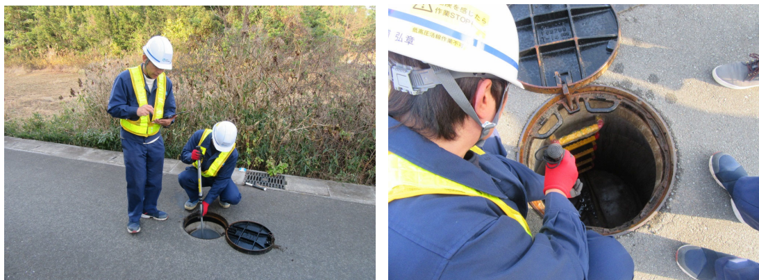
図 5-18 360° カメラによるマンホール内部の点検
