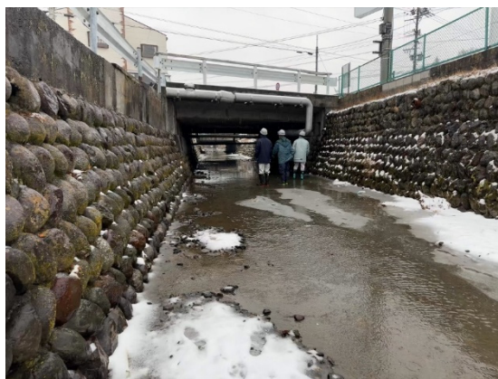
写真-2.3.1 実証点検状況写真(伊那市)
