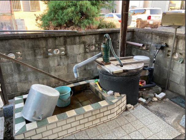
図 49 停電時における取水設備の
