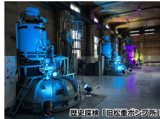
歴史探検「旧松重ポンプ所」
