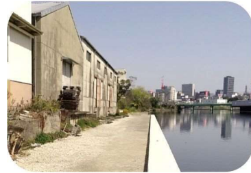
改修済みの護岸
