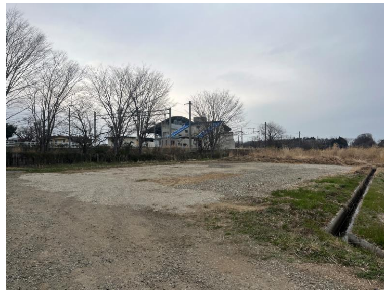
東口ロータリー整備予定地
