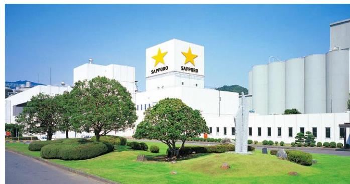
サッポロビール静岡工場と静岡麦酒 （出典：施設HP、サッポロビールHP）
