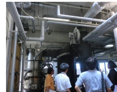
[道の駅たるみず湯つ足り館 / 鹿児島県垂水市]
