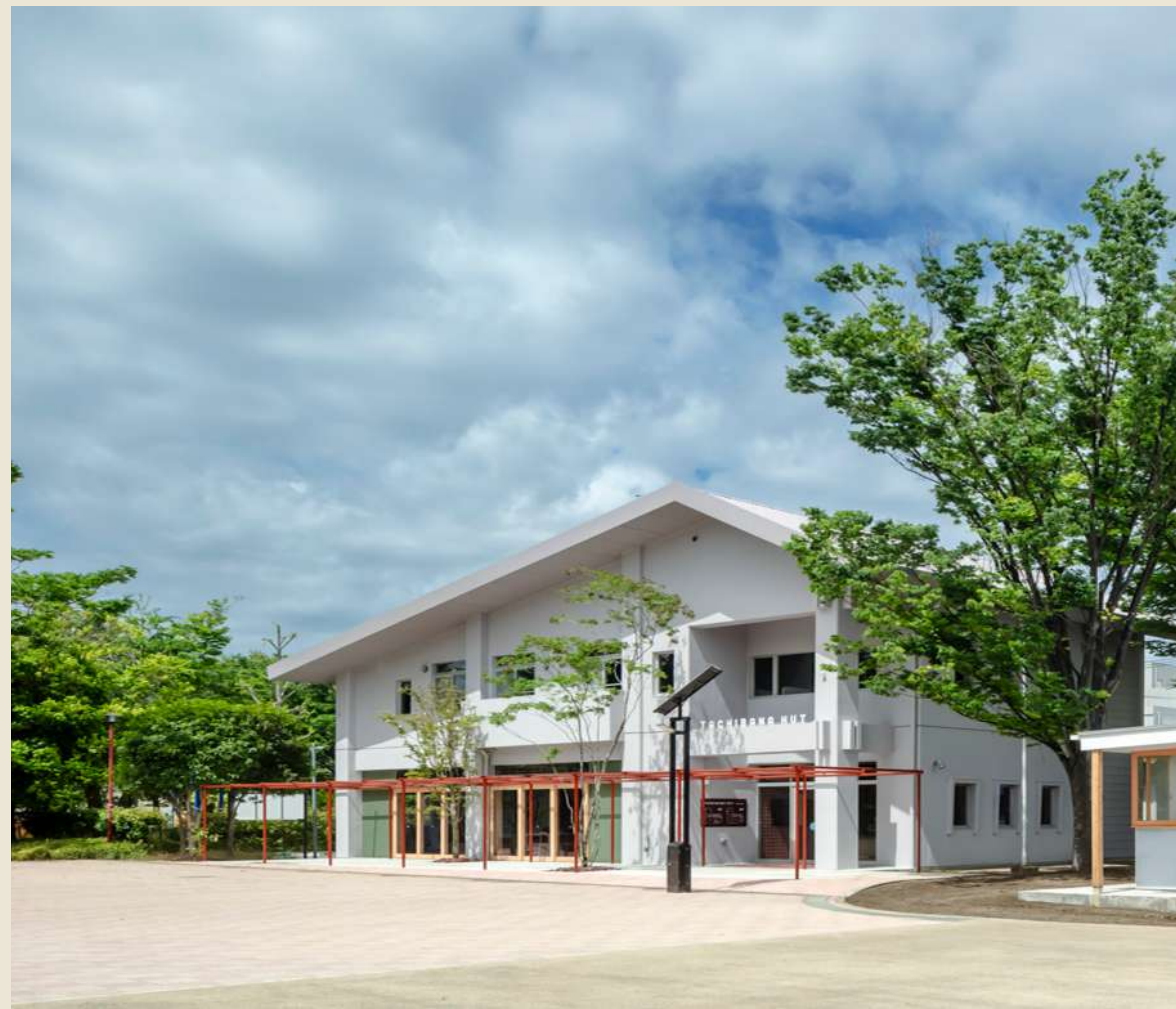
| 建物のリノベーション After
