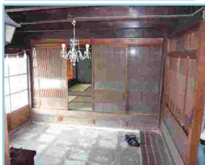
旧津倉家住宅主屋の玄関土間
