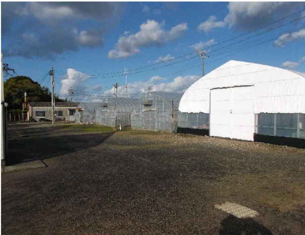
ハウス・ボイラー室（農業用）
