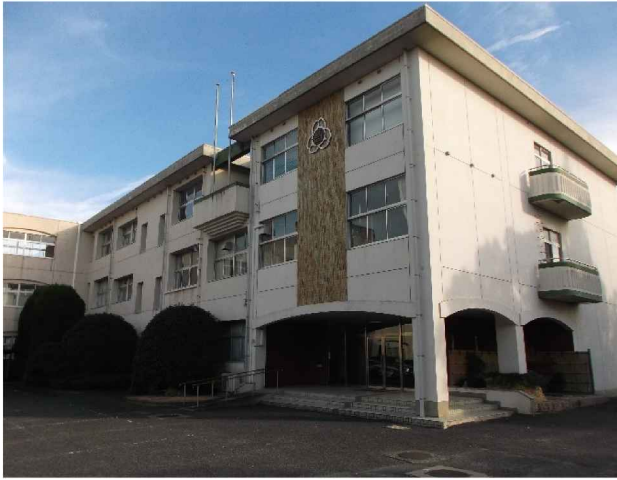
宇部西高等学校の主要な建物等 管理特別教室棟
