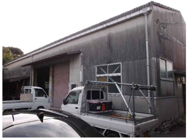
造園施工実習棟②
