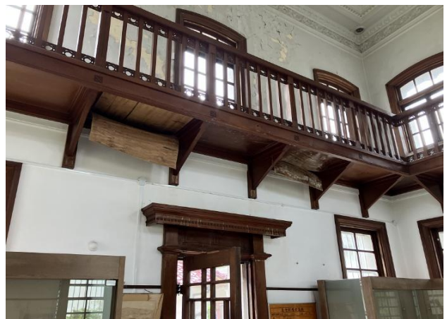
美作歷史資料館內部廊下床材
