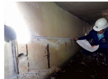
ひびわれ注入工 確認状況
