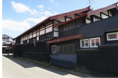
旧西谷家住宅外観（松の湯交流館側）
