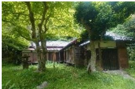
図 3-28 第二休憩所の外観
