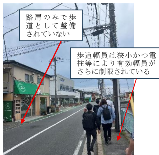
図 3-7 県道 24 号横須賀逗子線の道路状況 出所) 三井住友トラスト基礎研究所撮影
