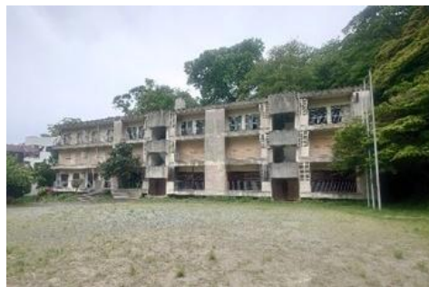
図 3-19 旧野外活動センターの外観 出所) 三井住友トラスト基礎研究所撮影
