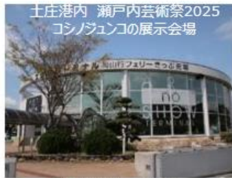
② 土庄港ターミナルビル (アートノショーターミナル)
